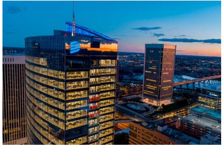
600 Canal Place, Richmond, Va.
